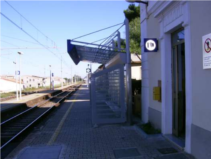
Pensilina autonoma per stazione con pannelli solari per alimentazione servizi.
